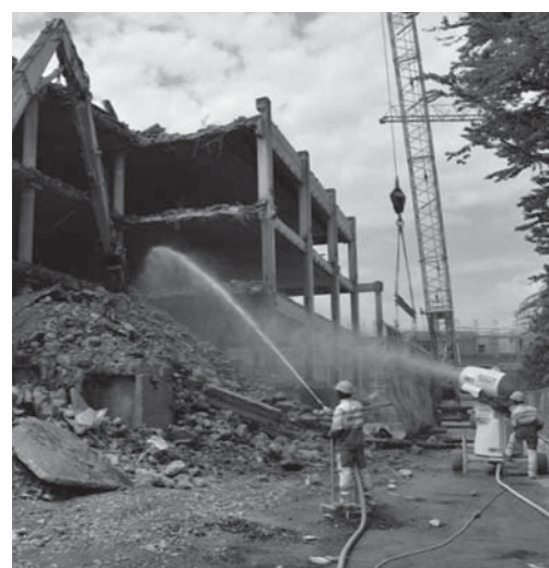
Fig. 5: réduction du dégagement de poussière au moyen de mesures appropriées, par ex. par projection d'eau sur l'engin de chantier ou par humidification avec de l'eau.
