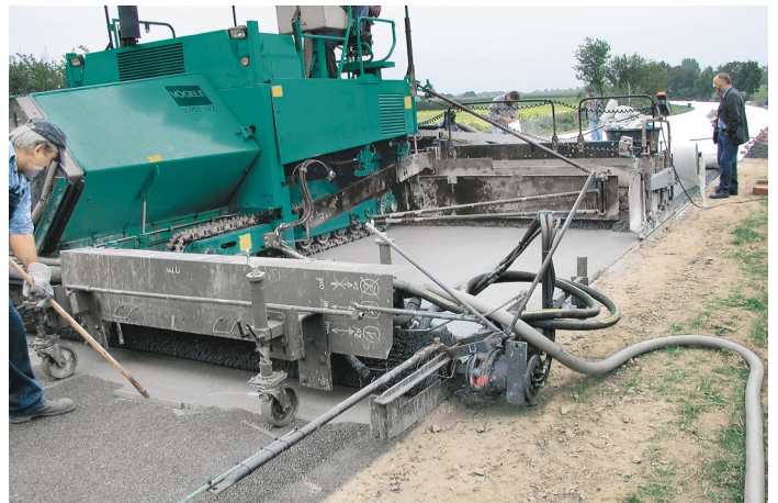
FINISSEUSES A BETON - RADIER—ROUTES
