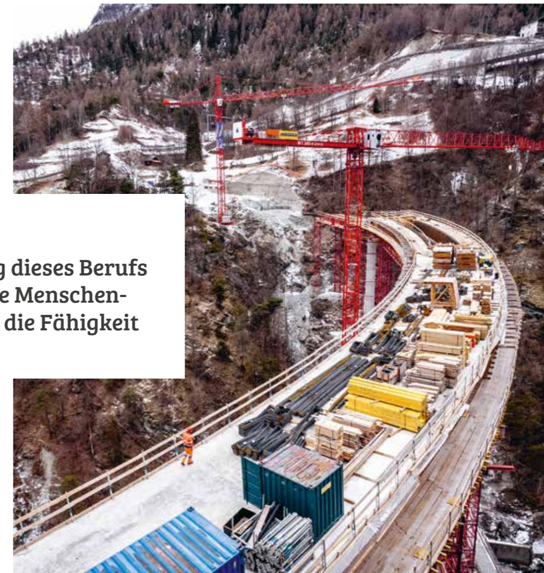
Bau der Chinegga-Brücke in Stalden.
