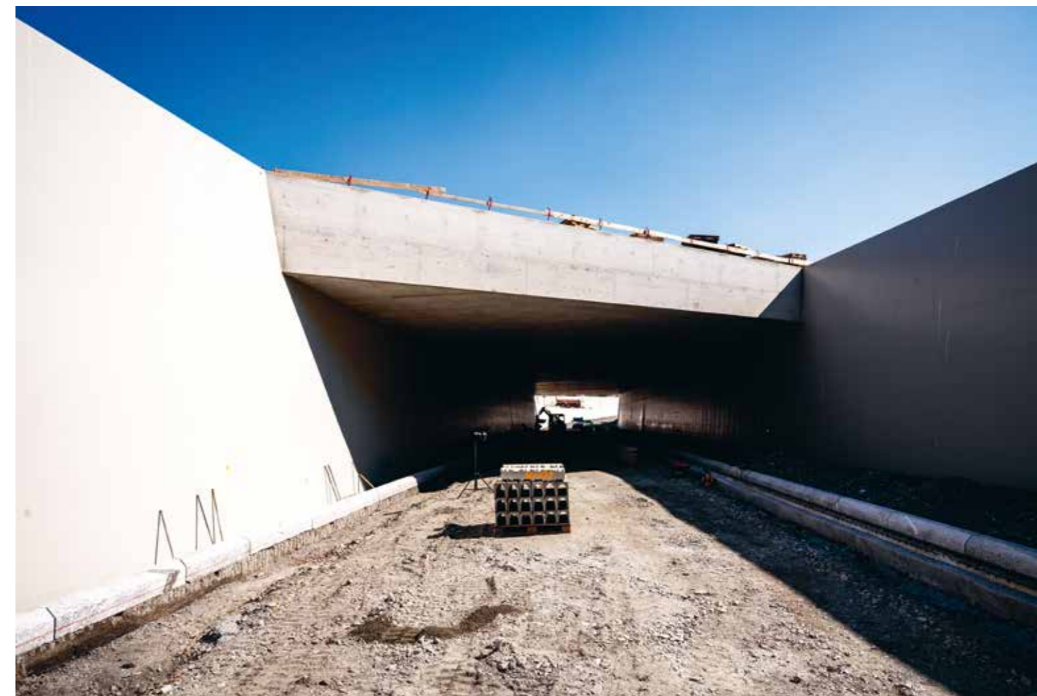
Baustelle der Autobahn A9.
