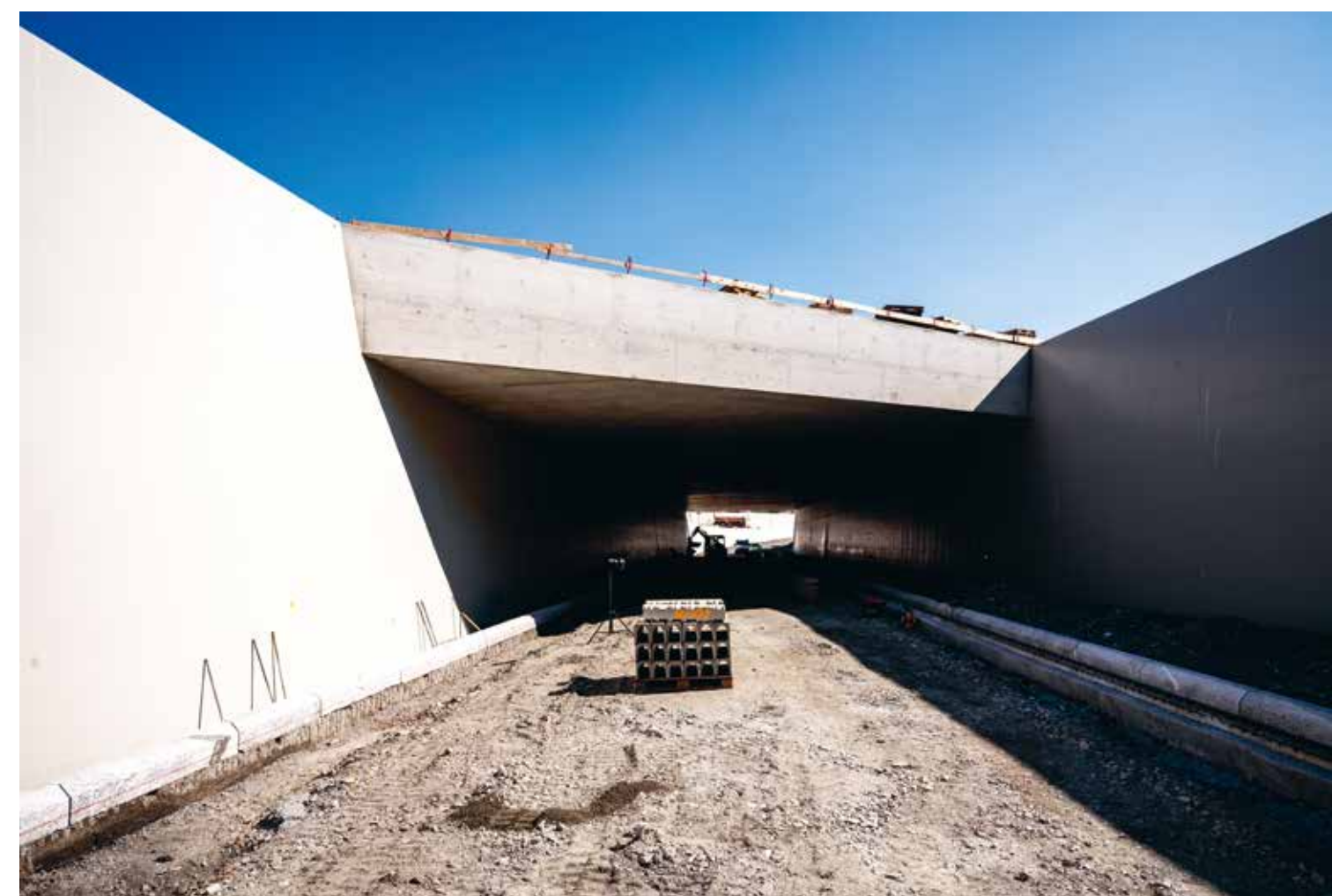
Chantier de l'autoroute A9.
