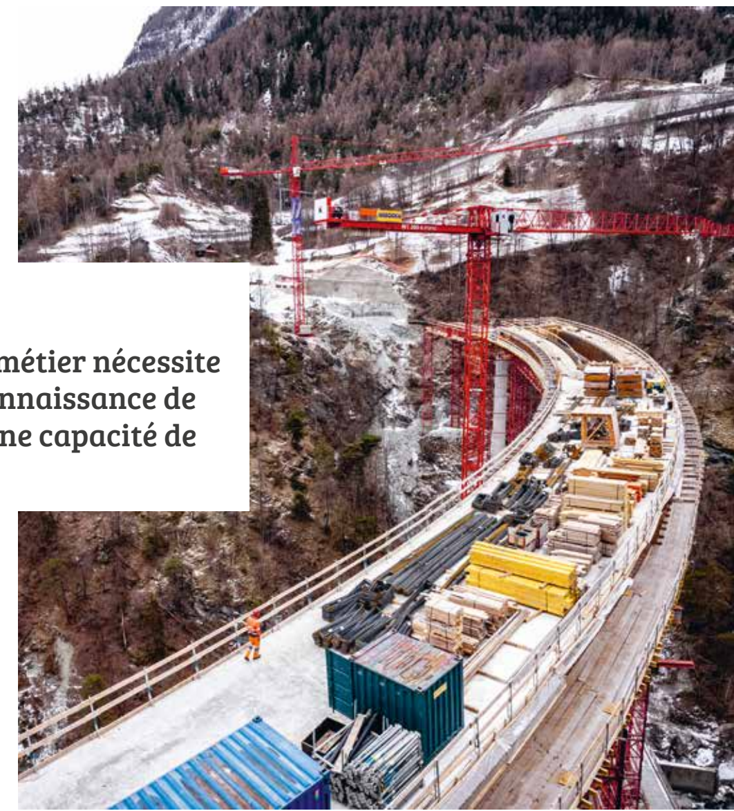
Construction du pont Chinegga à Stalden.
