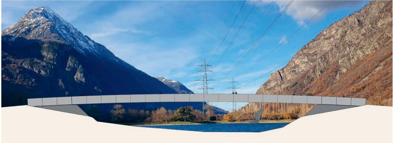
Modell der Überführung Rosel (Martinach) aus Hochleistungs-Stahlfaserbeton.
