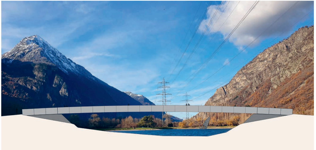
Maquette de la Passerelle du Rosel (Martigny), en béton fibré de haute performance.
