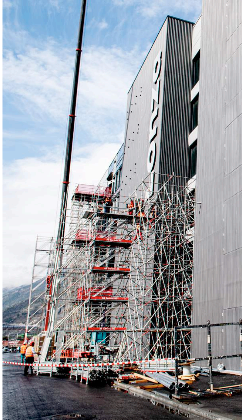
↑ Bâtiment de la Lonza, Viège
