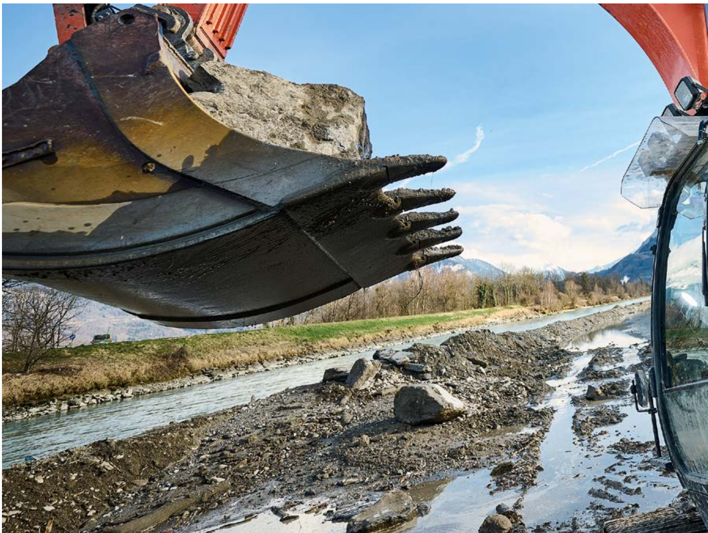
Platzierung von Uferbefestigungen am Rhone mit einem Bagger, der präzise durch Satellitenführung gesteuert wird.
