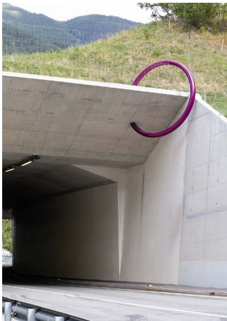
3PUNKT44 de Sibylla Walpen, une intervention sculpturale installée sur la galerie du tunnel de Stalden
