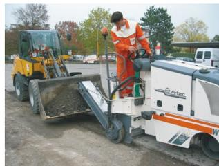
FRAISEUSES A FROID AVEC CONVOYEUR
